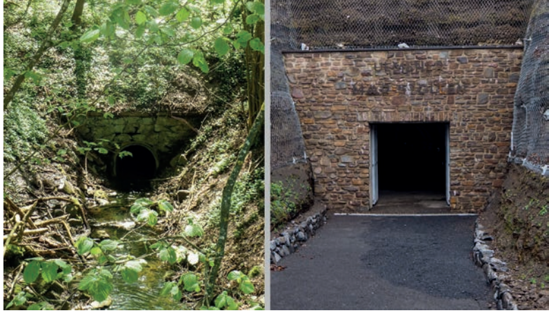
Nordseite des Ulmener Maar-Stollens vor dem Ausbau (links, 2012) bzw. nach dem Ausbau (rechts, 2023).
