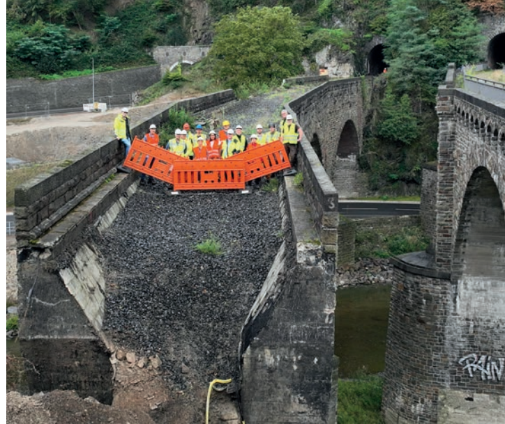
Teilnehmer der AG Geogefahren der Geologischen Landesdienste auf einer durch die Ahrflut zerstörten Brücke bei Altenahr.
