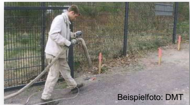
Schlauchverbindung zu den Verfüllbohrungen
