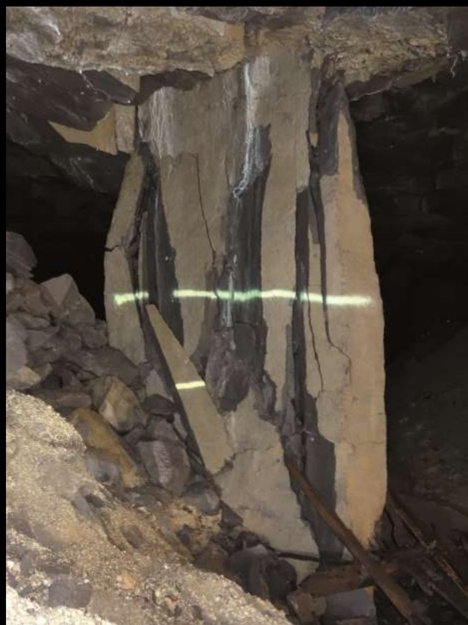
Pfeiler mit rezenter Spaltbruchentwicklung – Januar 2014 und August 2015 (Fotos BOCK)
