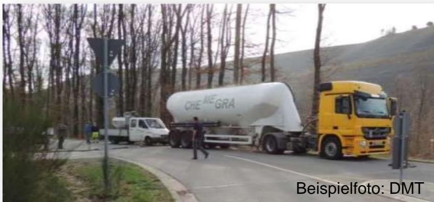
Verfüllbaustelle mit Silofahrzeug und Pumpe
