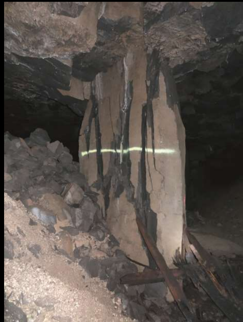
Pfeiler mit rezenter Spaltbruchentwicklung – Januar 2014 und August 2015 (Fotos BOCK)
