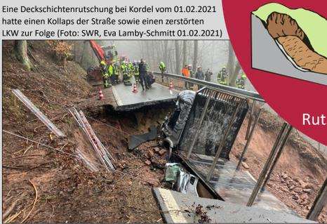
Eine Deckschichtenrutschung bei Kordel vom 01.02.2021 hatte einen Kollaps der Straße sowie einen zerstörten LKW zur Folge (Foto: SWR, Eva Lamby-Schmitt 01.02.2021)
