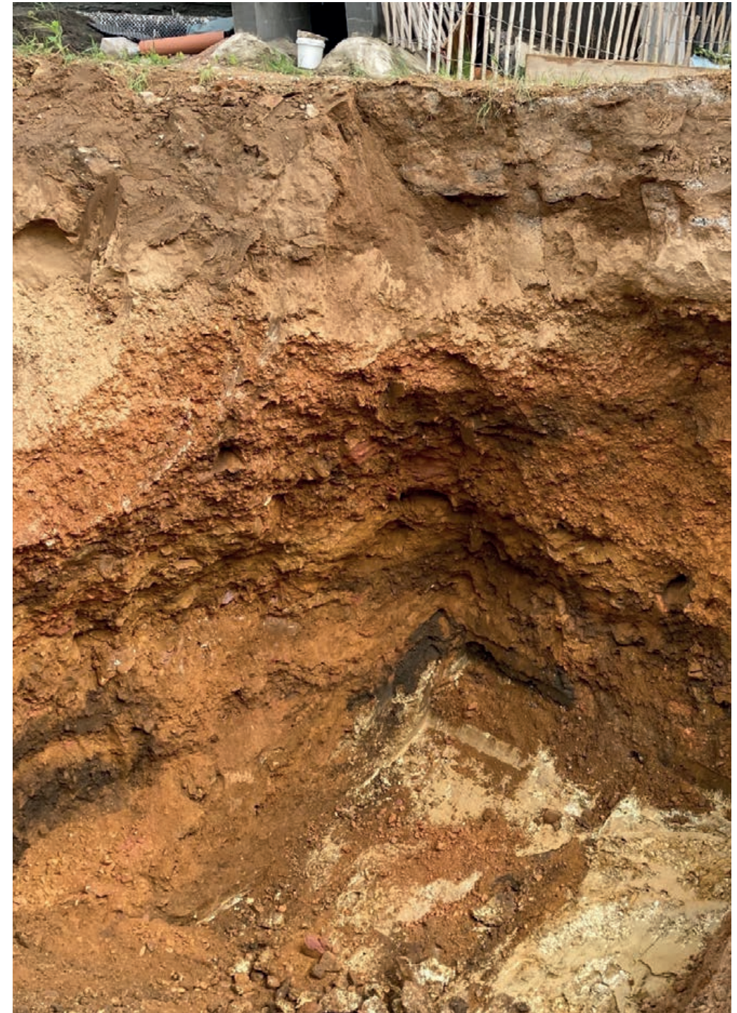
Abb. 5: Ablagerungen der t4-Terrasse (Kandler 1970) in einer Baugrube im Gleisbergweg in Mainz-Gonsenheim aus dem Jahr 2024 (Foto: M. GRIMM). Unter Umlagerungen, einer geringmächtigen Bodenbildung und hellem Flugsand liegt die t4-Terrasse verwürgt über dem Kalktertiär.
