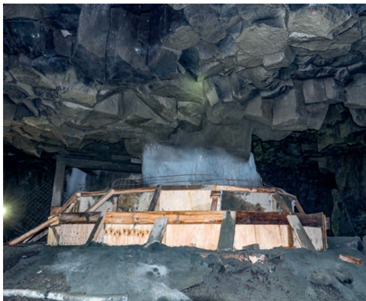
Sichern eines Basaltpfeilers mit einer Stahlbetonummantelung neben dem neuen Schacht.
