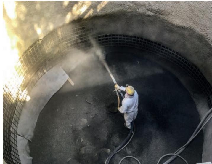
Herstellen des Schachtes in Spritzbetonbauweise.
