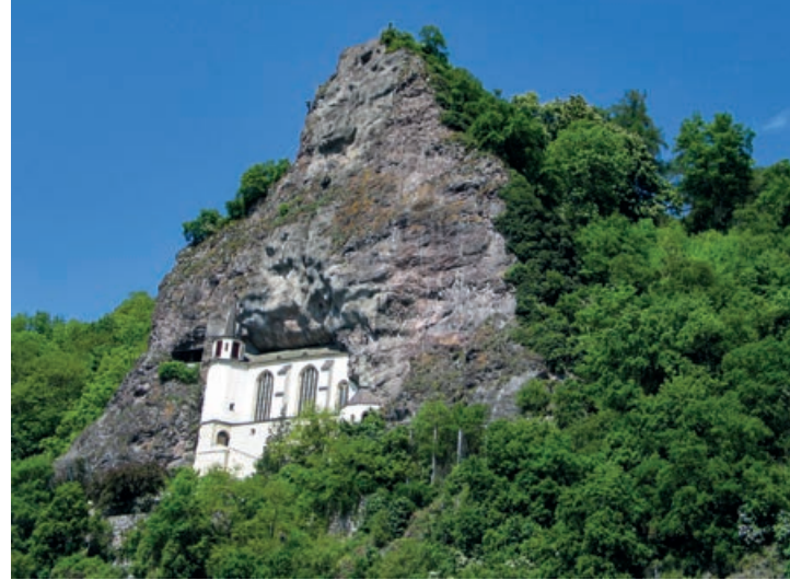
Sicherungsarbeiten bei der Felsenkirche in Idar-Oberstein.
