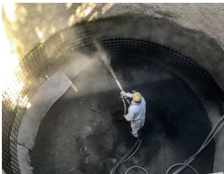
Herstellen des Schachtes in Spritzbetonbauweise.
