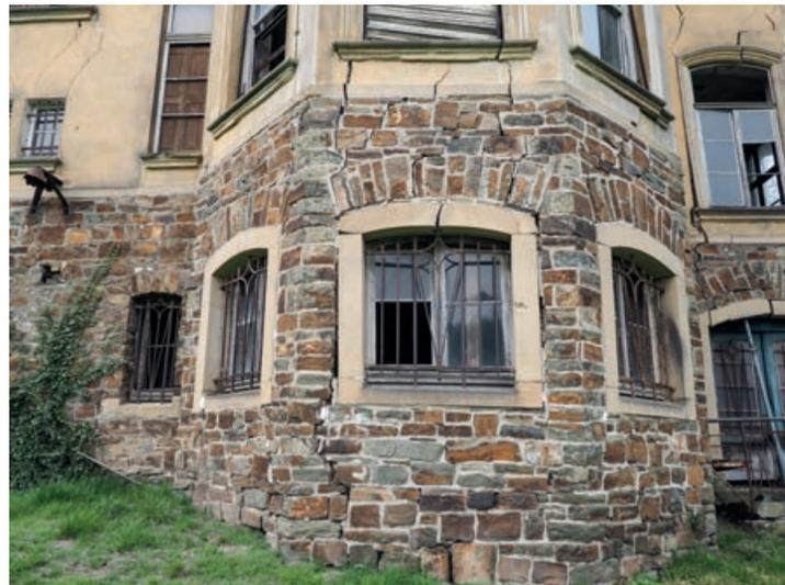
Prüfung einer denkmalgeschützten historischen Villa am Mittelrhein im Auftrag der GDKE. Die extremen Risschäden sind die Folge einer unzureichenden Gründung im Hanggelände bei „schwachem“ Baugrund.
