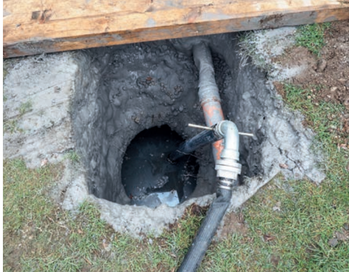
Blick in ein Verfüllbohrloch. Hier wurde im Bereich eines alten Schachtes ein Hohlraum vorgefunden, der ebenfalls verfüllt wurde.
