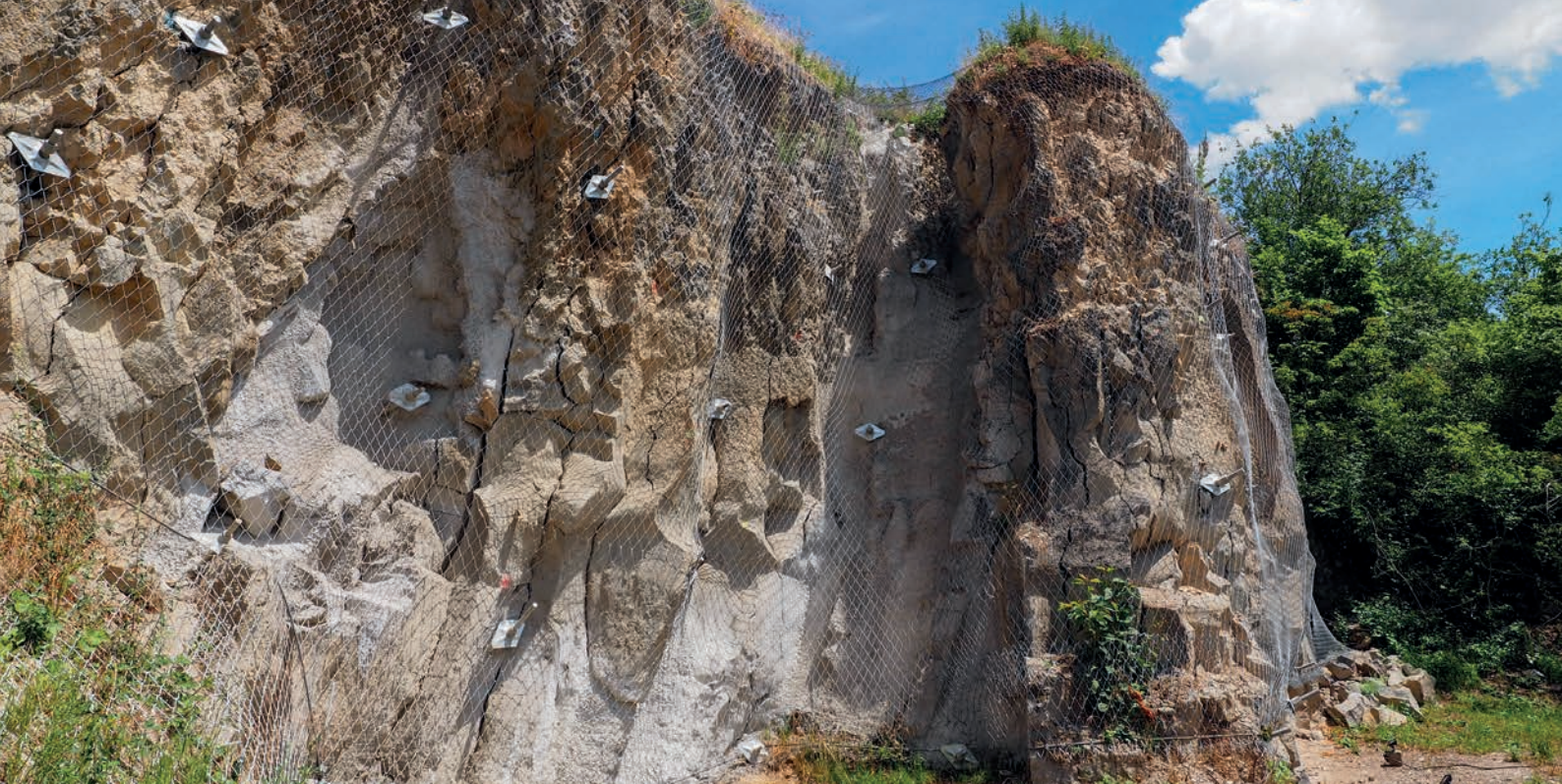
Situation nach Fertigstellung der Sicherungsarbeiten (Foto: Juni 2022).
