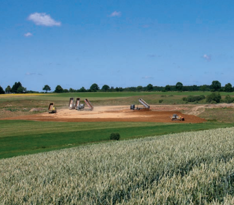
Abschließende Erdarbeiten bei der Wiedernutzbarmachung (links) und Endzustand (rechts) des Tagebaus "Max" bei Dierdorf-Wienau im Westerwald. Fotos: Gerd Klemmer (SIBELCO Deutschland GmbH).
