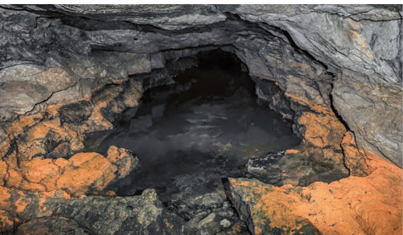
Hinter mehreren Verbrüchen staute sich Wasser im Stollen.
