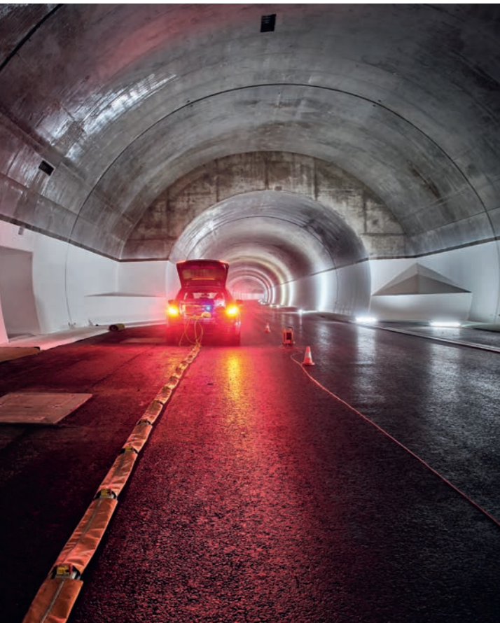
Messungen im Tunnel von Bad Bergzabern.
