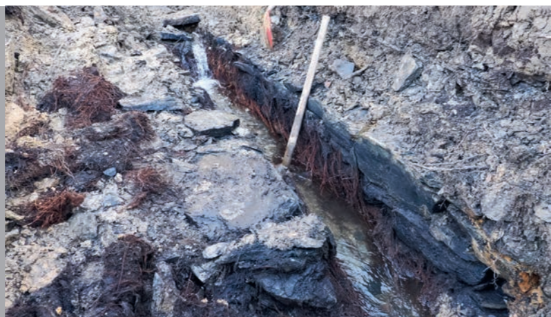
Freilegung der Rösche im Bereich des alten Stollenmundlochs.
