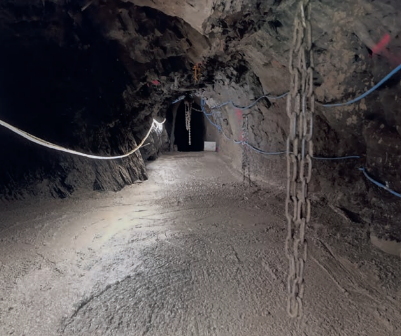
Guss des 80 cm hohen Betonsockels des Wasserdamms.
