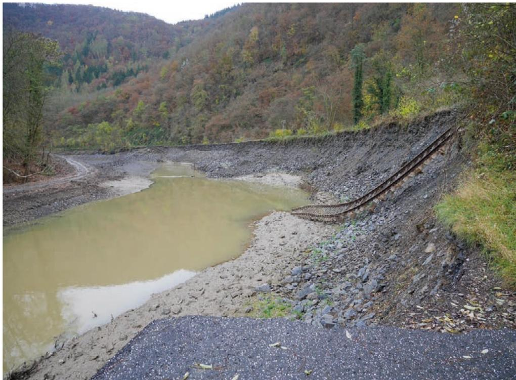
Massive Prallhangerosion an der Ahrschleife südlich von Laach / Lochmühle. Durch die Erosion wurde hier die Bahntrasse vollständig zerstört. Foto K. KURZ.
