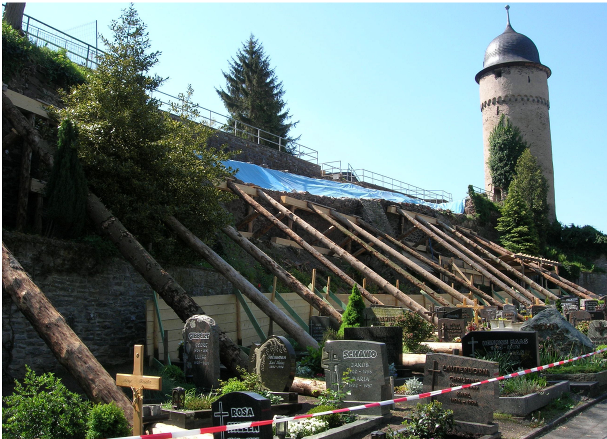
Abb. 2: Provisorische Abstützung einer durch Rutschmassen einsturzgefährdeten Mauer
