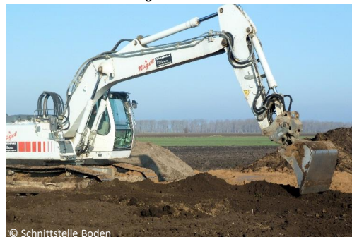
Herstellung einer durchwurzelbaren Bodenschicht
