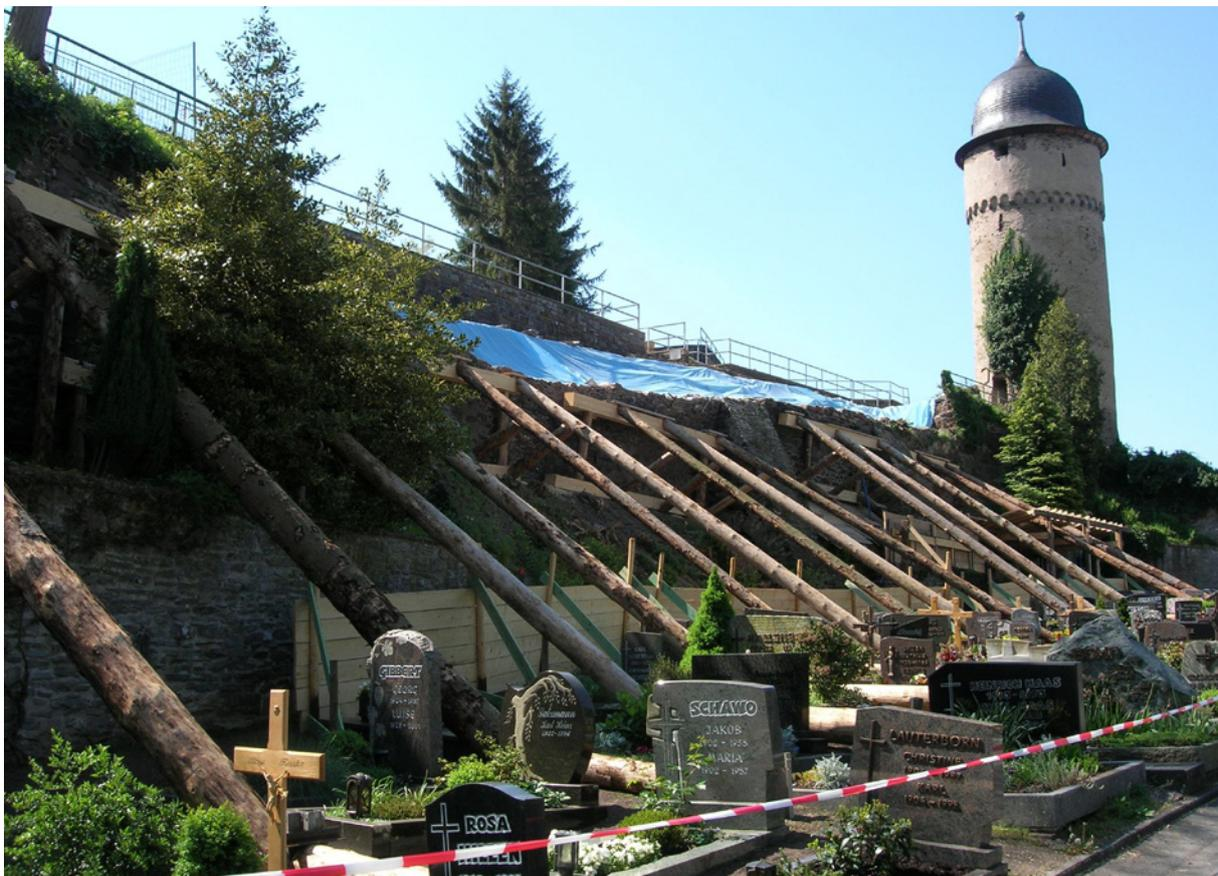
**Abb. 2: Provisorische Abstützung einer durch Rutschmassen einsturzgefährdeten Mauer**
