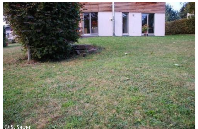
Versickerungsmulde auf privaten Grundstück
