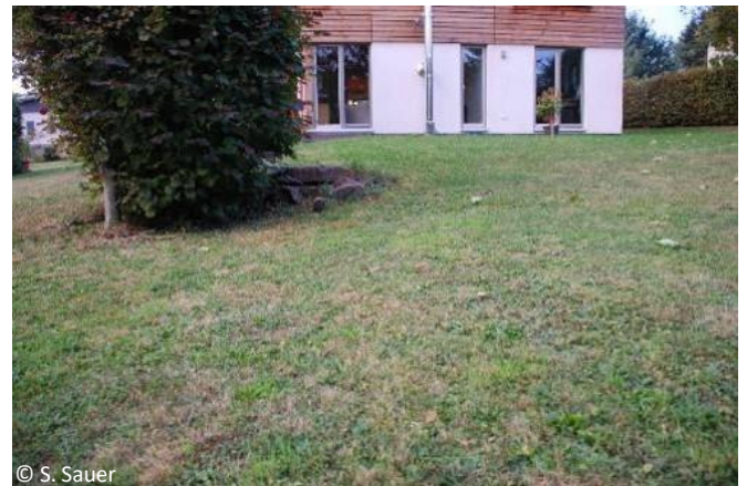
Versickerungsmulde auf privaten Grundstück
