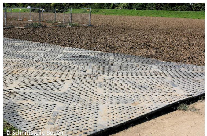
Baustraße und Abgrenzung von Tabuflächen im Rahmen der BBB
