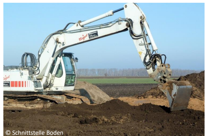
Wiedereinbau von Oberbodenmaterial
