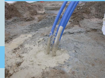
Eingebaute Erdwärmesonde
