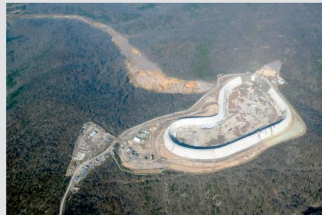
Das Bild zeigt den Neubau des Oberbeckens des Taum Sauk Pumpspeicherkraftwerks nach dem Dammbbruch.
