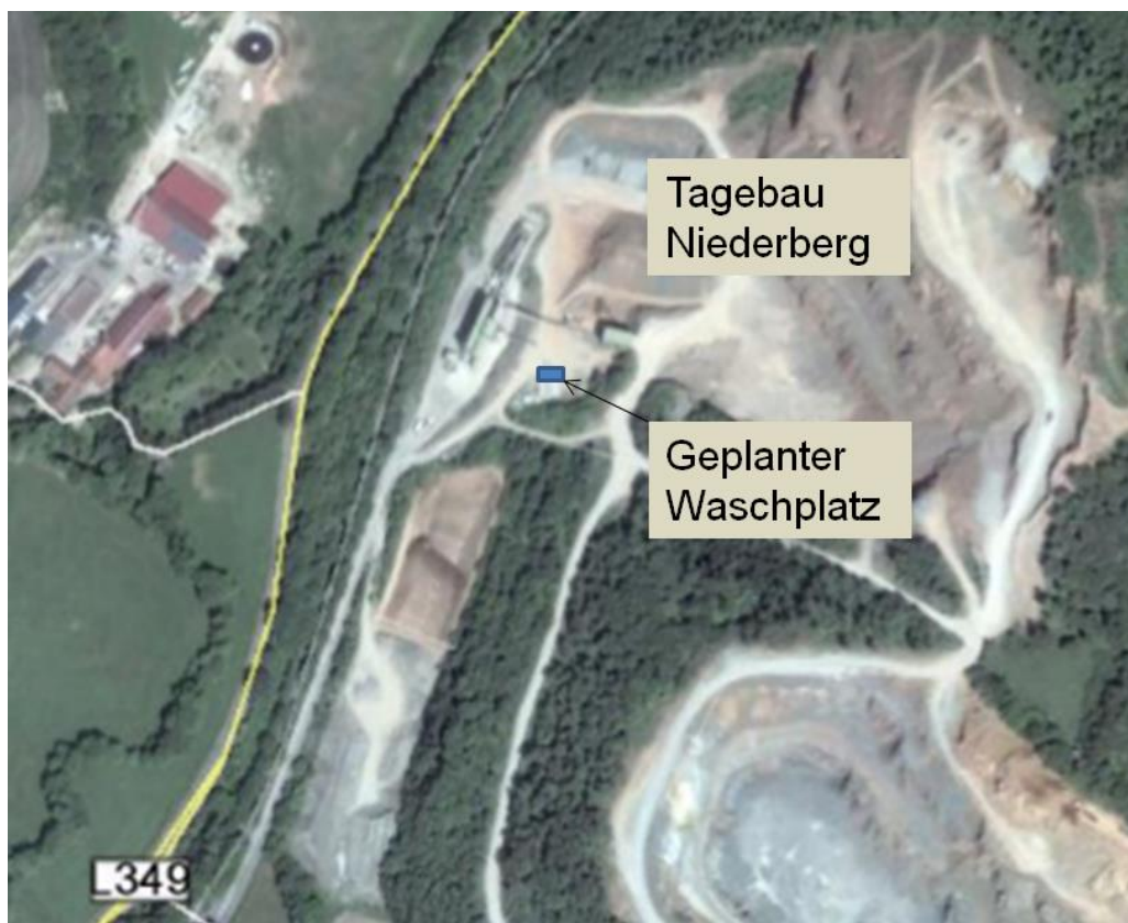
Abbildung 1: Tagebau Niederberg und geplanter Standort Waschplatz (Quelle: Google Earth)
