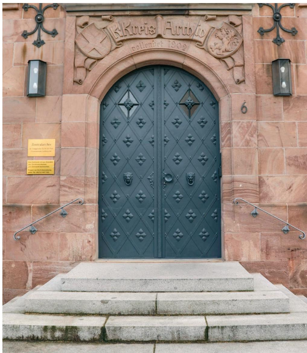
Abb. D-16: Portal des Kreisarchivgebäudes mit Treppentufen aus Granit (Foto HÄFNER 2024).
