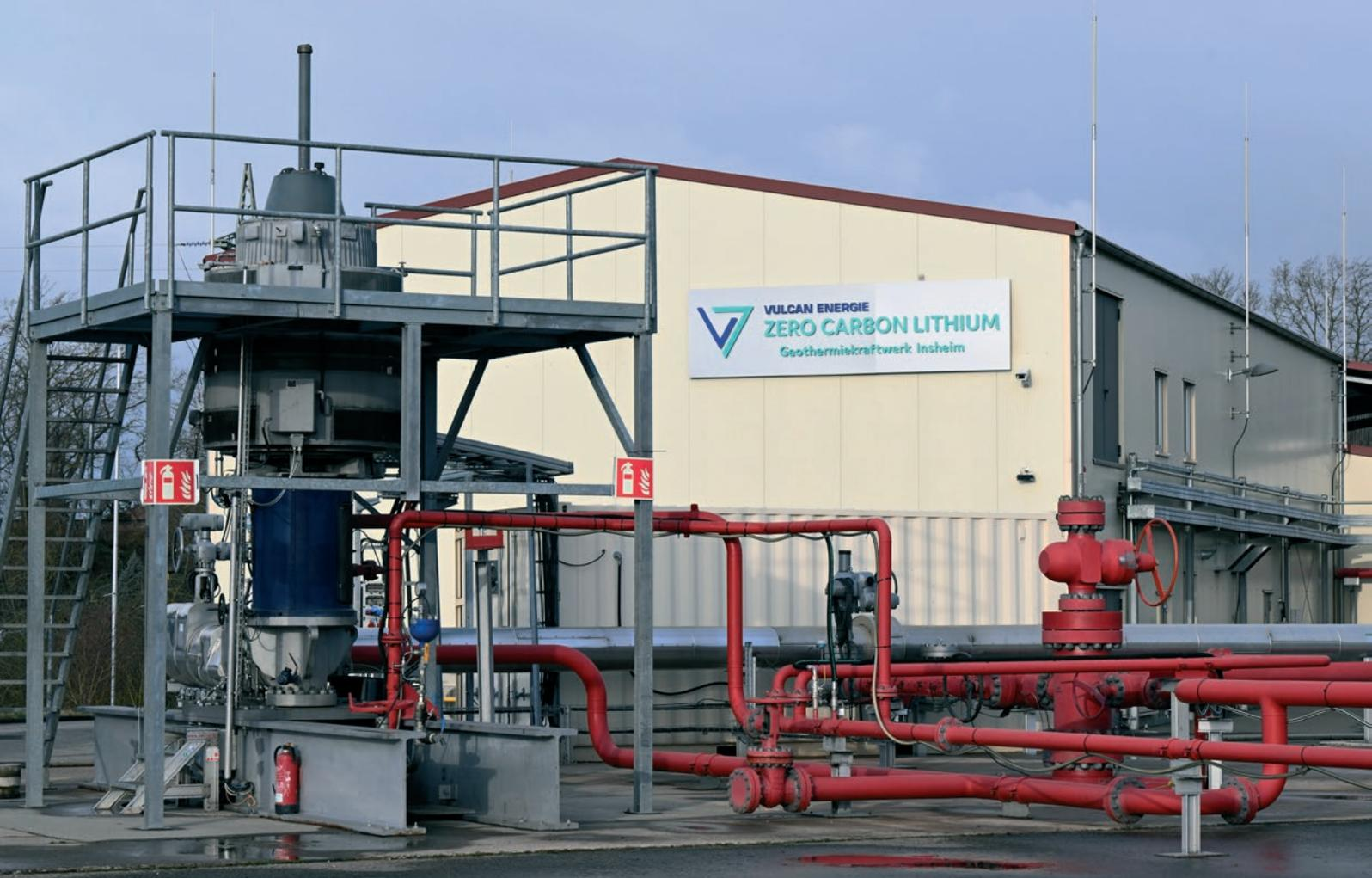
Abb. B-4: Geothermiekraftwerk "Natürlich Insheim". Links im Bild die Förderbohrung mit Pumpe, rechts die Reinjektionsbohrung (Quelle: VULCAN ENERGIE RESSOURCEN GmbH).
