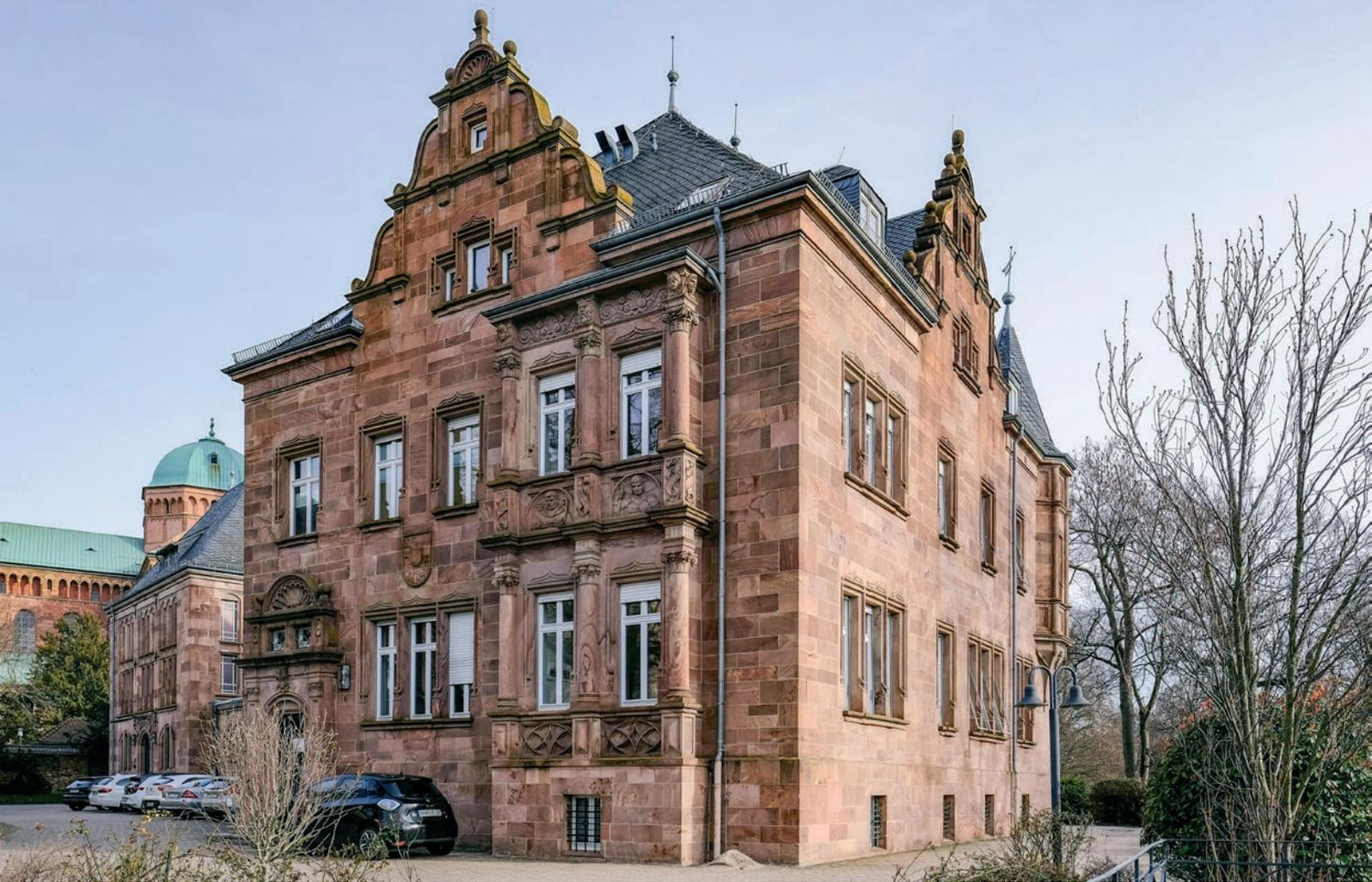
Abb. D-15 (oben): Ansicht des früheren Kreisarchivgebäudes aus Olsbrücker Sandstein (Foto GRUBERT 2024).
