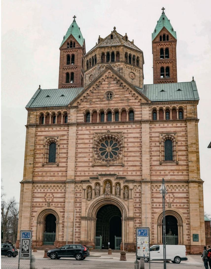
Abb. D-14: Ansicht des Kaiserdomes von Westen mit Mauerwerk aus pfälzischen Sandsteinen (Foto HÄFNER 2024).
